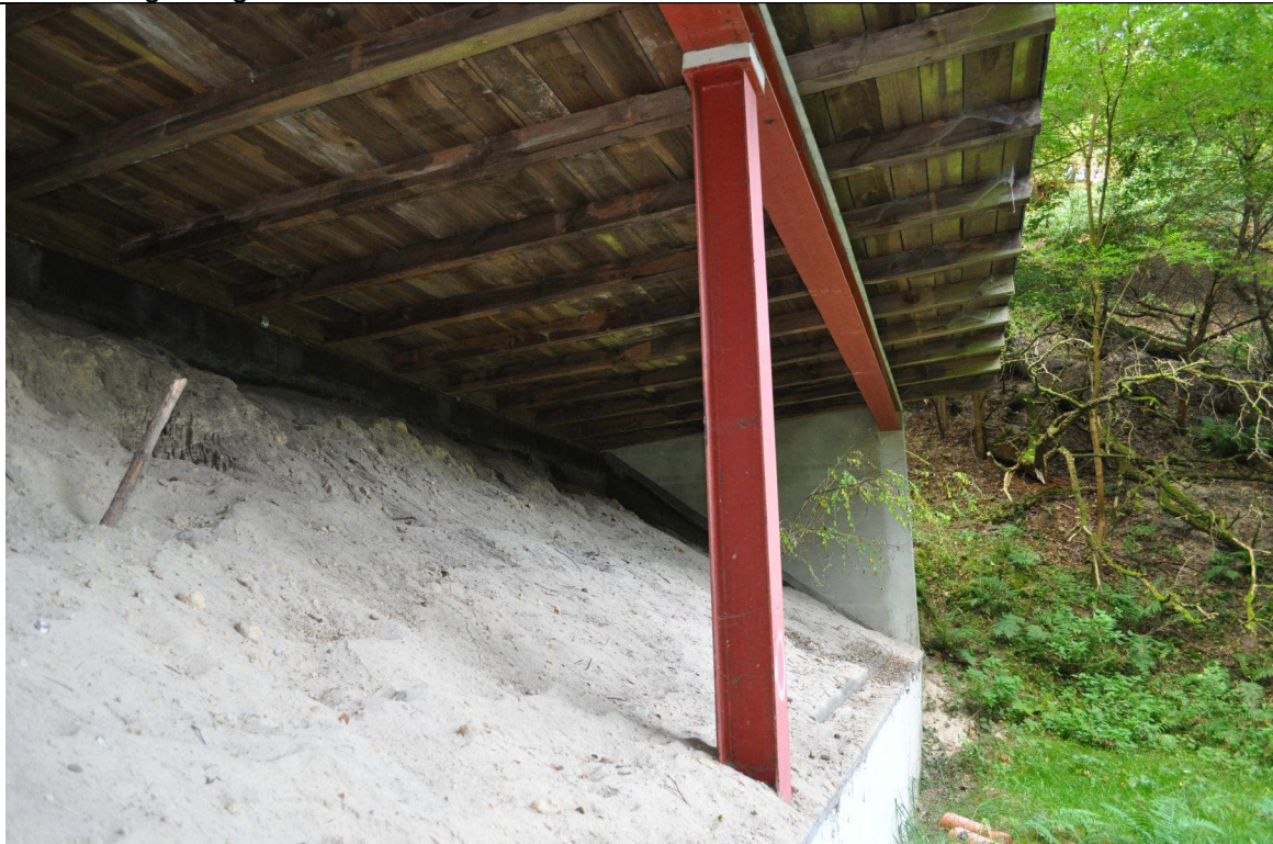
Bild 4: Kugelfang
