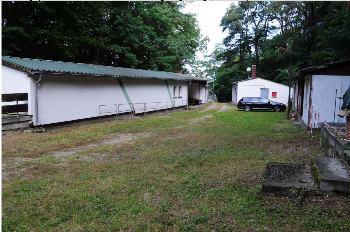
Bild 2: Standort geplanter Schießstand, Blickrichtung Nord
